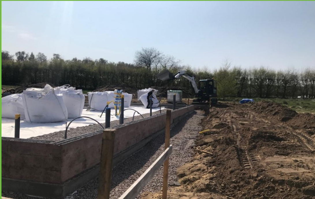
Perlitegrund under uppbyggnad
